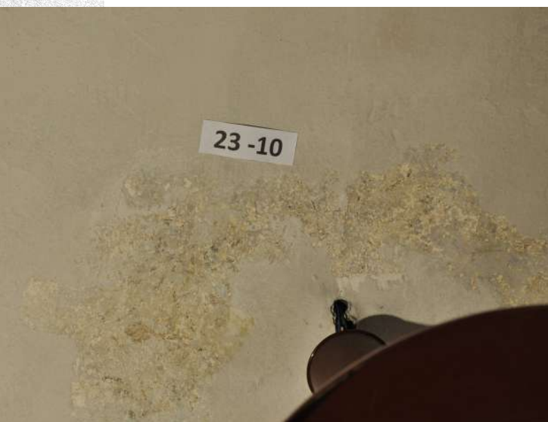
Fot. 16 - Fragmenty rozety odsłonięte podczas badań.
